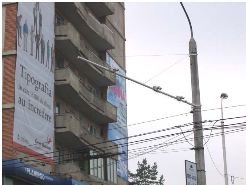
Fig. 7-1 Senzori PIR pentru detecția vehiculelor rutiere și evaluarea parametrilor de trafic, montați în intersecția Ana Ipătescu – Bd. Nicolae Bălcescu
